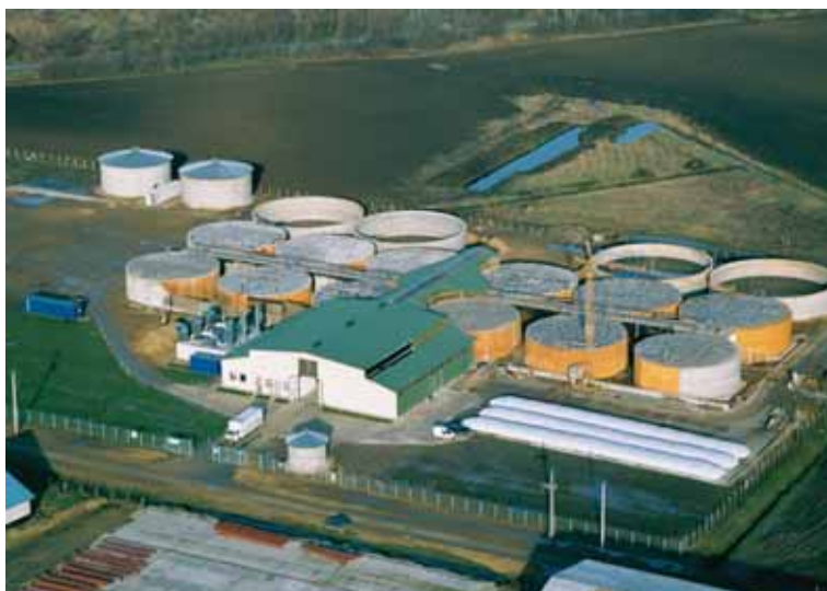
MADÁRTÁVLA TI KÉP A NYÍRBÁTORI BIOGÁZ ÜZEMRŐL / BIRD'S EYE VIEW OF THE BIOGAS PLANT IN NYÍRBÁTOR
