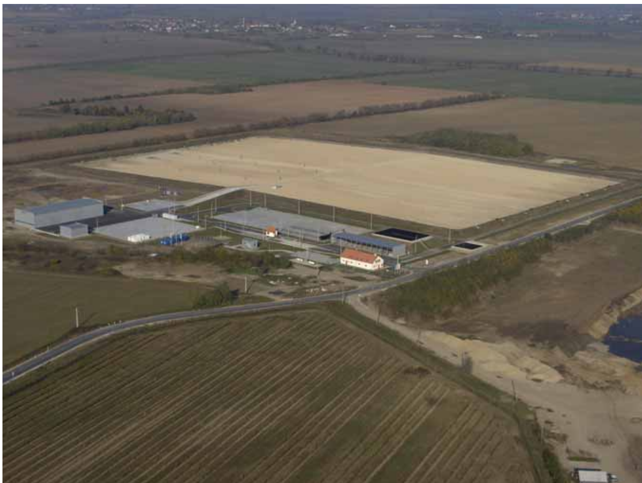
HEJŐPAPI REGIONÁLIS HULLADÉKKEZELŐ TELEP / HEJŐPAPI REGIONAL WASTE MANAGEMENT PLANT
