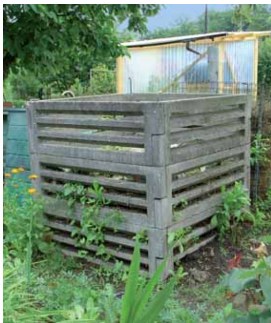
IDÓTÁLLÓ KOM- POSZTÁLÓ – BETONELEMEKBŐL / A COMPOSTER THAT CAN RESIST THE EFFECTS OF TIME – MADE OF CONCRETE PARTS
